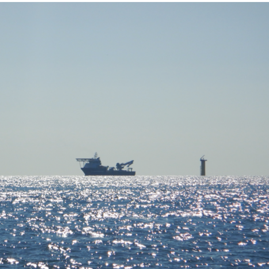
← Installation d'une ferme éolienne offshore.
