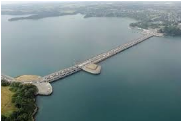
Usine Marémotrice de la Rance
